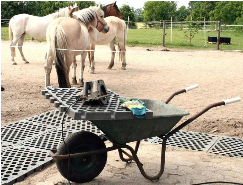
Bodengitterplatten als Unterbau lassen sich per Handkreissäge schnell zuschneiden
